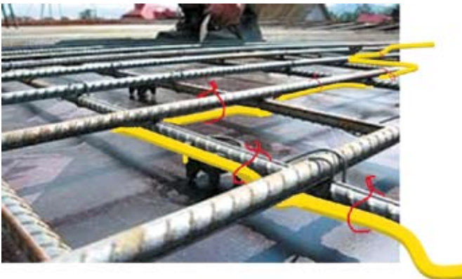
Рис. 5. Крепление кабельных сенсоров влажности к арматуре перед заливкой бетона
